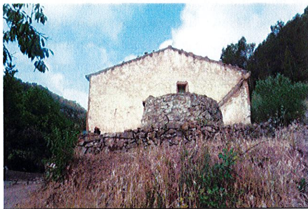
Mas del Vinyeta. Une citerne stocke l'eau de pluie captée par le toit
